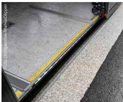
**Eine Haltekante von 22 cm Höhe ermöglicht einen niveaugleichen Einstieg zum Bus.**
